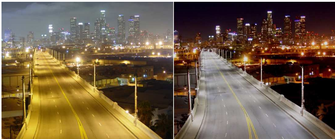
Figura 02 – À esquerda, via iluminada com vapor metálico e à direita via pública iluminada com Luminárias com lâmpadas à LED. Projeto sustentável, com 60% de economia, iluminação mais homogênea gerando mais segurança aos usuários.
